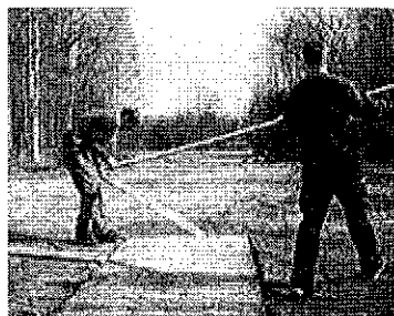
Gjutning av betongplattor Foto: Jonas Rudholm
