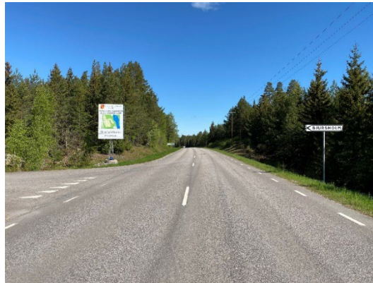
Bild 15 Avfart från/påfart till länsväg 580 i norrgående riktning.
