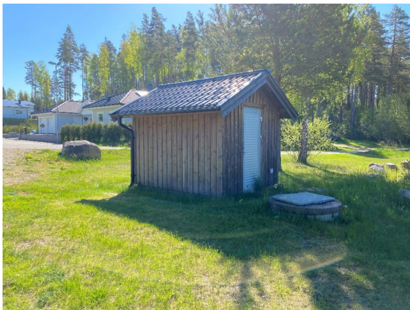
Bild 17 Pumpstationen som är centralt placerad i området.
